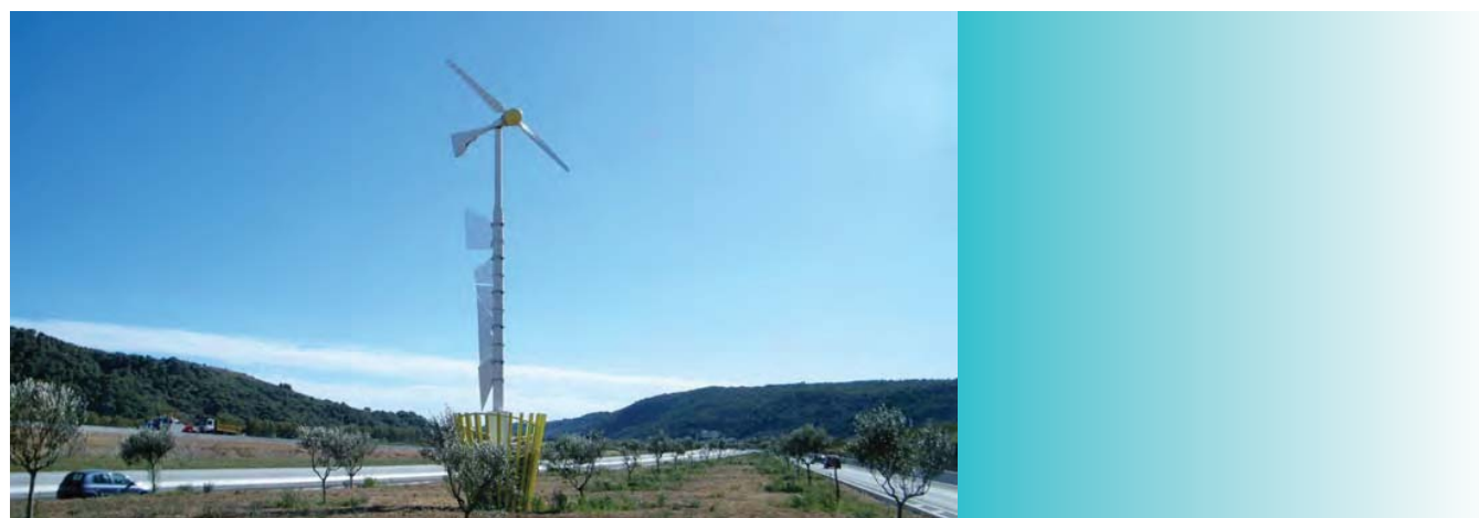
> Eolienne sur la RD 6202 bis (© EPA)
